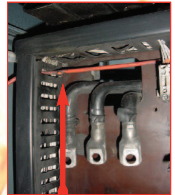
Note tube bursts after actual fires
