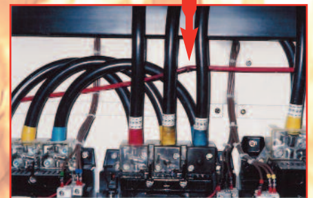
Note tube bursts after actual fires
